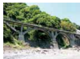
第二領地橋梁(高知県)
