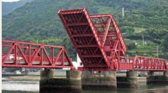
写真-1 開閉中の長浜大橋 [2]
