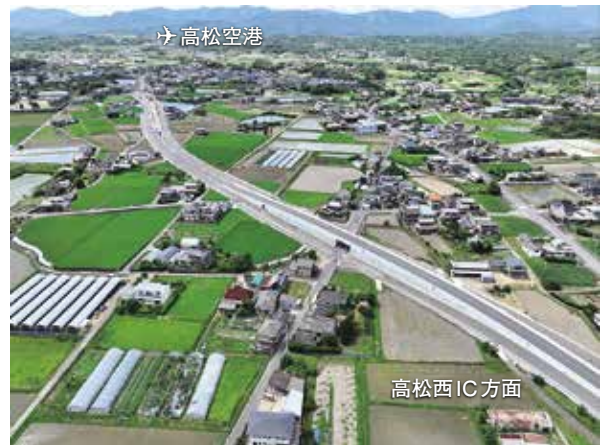
整備が進む高松空港連絡道路
