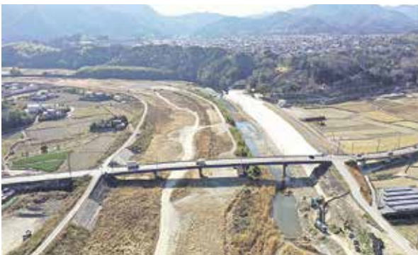
園瀬川(堤防の整備)
