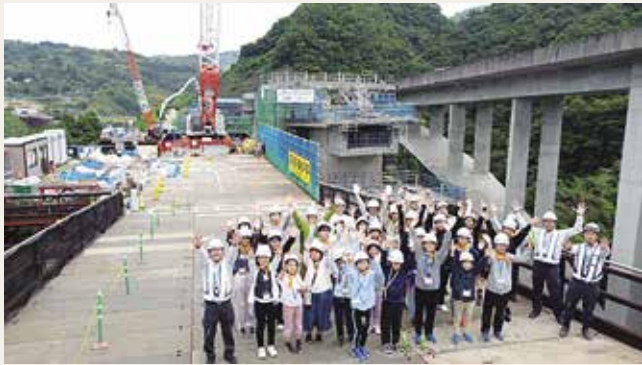
写真-6 松山自動車道で進む松山～大洲間の4車化工事(未来を担う子供達が高速道路建設の迫力に目を見張る、中島淳子氏提供)
