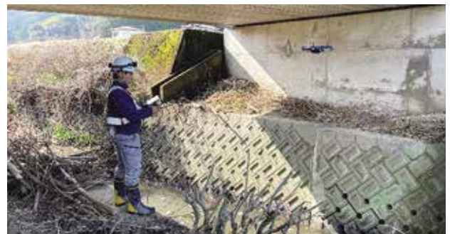
UAVによる橋梁点検
