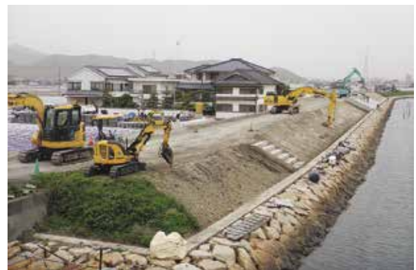
撫養川(堤防の耐震化)
