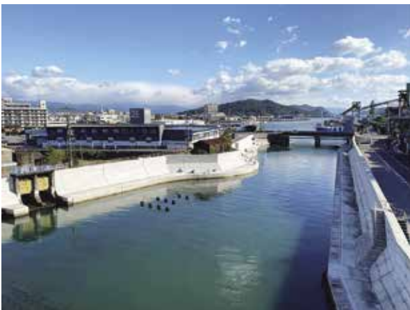
整備が進む高知港海岸(潮江地区)
