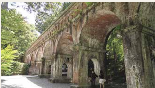
写真-2 観光名所になっている南禅寺境内の水路橋(景観に配慮してレンガ、花崗岩造りのアーチ形式の橋脚、山本浩司氏提供)
