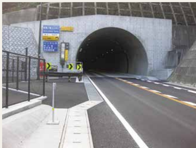
2020年に完成した新猪ノ鼻トンネル
